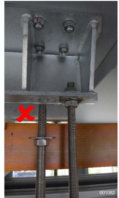
União roscada desapertada
